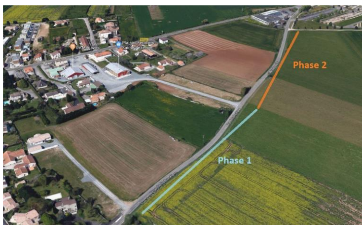
Vue aérienne de la zone du projet
