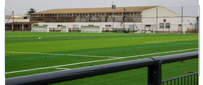
Stades (terrain synthétique, éclairage)
