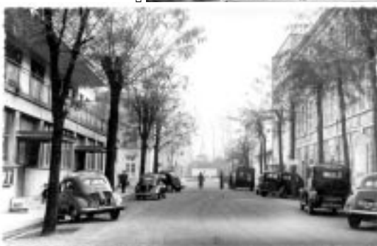
Hôpital Georges-Renon, allée centrale.
