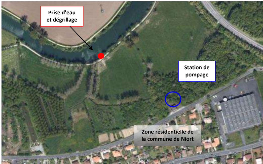
Figure 24 : Photo aérienne présentant l'environnement de la prise d'eau de Galuchet (Source : Google)
