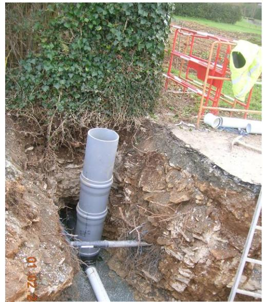
Figure 3 : réalisation d'un branchement
