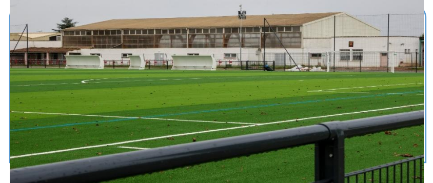
Stades (terrain synthétique, éclairage)
