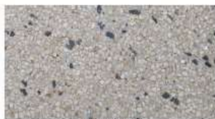
Béton désactivé voirie piétonne et circulée
