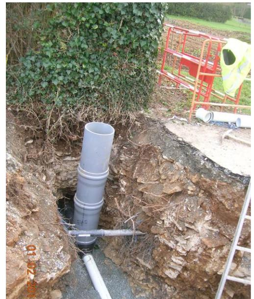
**Figure 3 : réalisation d'un branchement**
