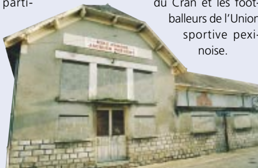
Avec la rénovation de l'ancienne école Jacques-Prévert, Sainte-Pezenne va s'enrichir d'un outil utile à toutes les associations du quartier.
